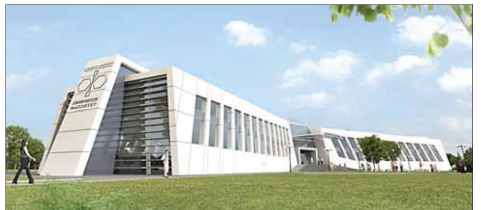
Отделните плътни части са покрити с окачена фасада от HPL панели. Наклонът на отворите за прозорци създава усещане за това как частите на триадата притискат и дори деформират стъкленото ядро
