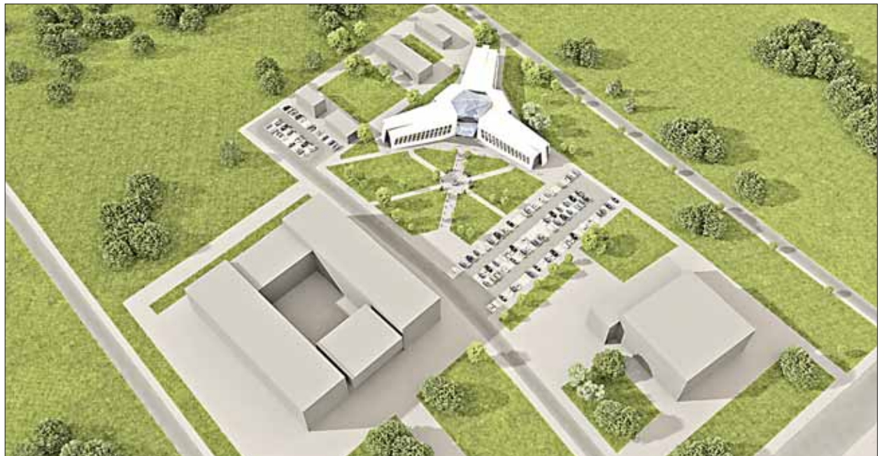
Бъдещата двуетажна монолитна сграда на Химическия факултет е в непосредствена близост до основната сграда на университета и новата спортна зала
