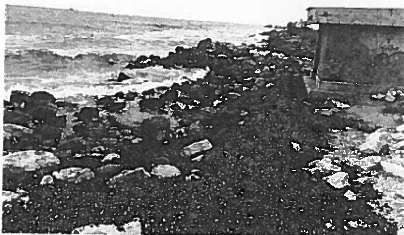
Фиг. 12 Участък 5 (снимка „Хидроремонт ИГ“, септ. 2015 г.)
