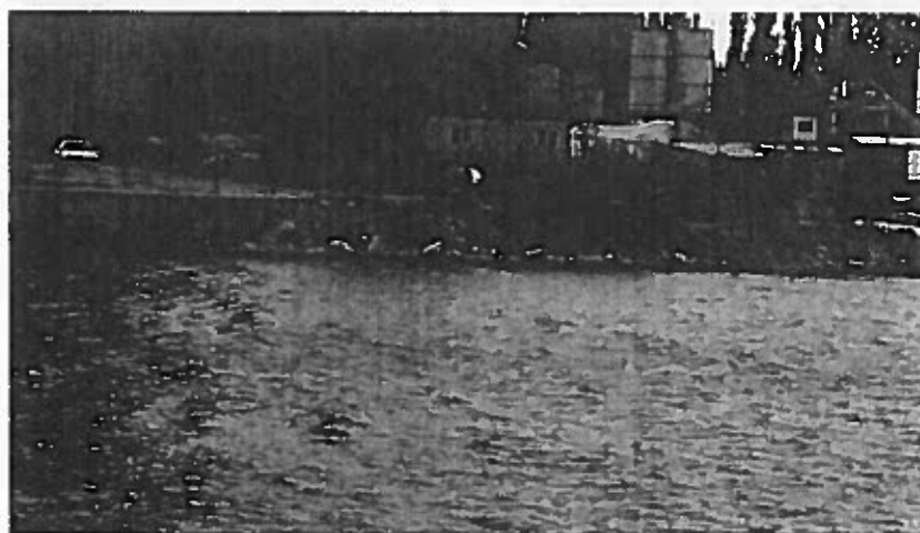
Фиг. 2 Северната част на участък 1 (снимка „Хидроремонт ИГ“, септ. 2015 г.)
