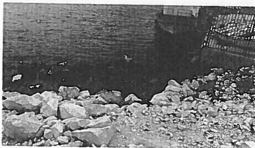
Фиг. 10 Участък 4 (снимка „Хидроремонт ИГ“, септ. 2015 г.)
