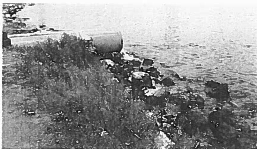
Фиг. 6 Съществуваща техническа комуникация в участък 2 (снимка „Хидроремонт ИГ“, септ. 2015 г.)
