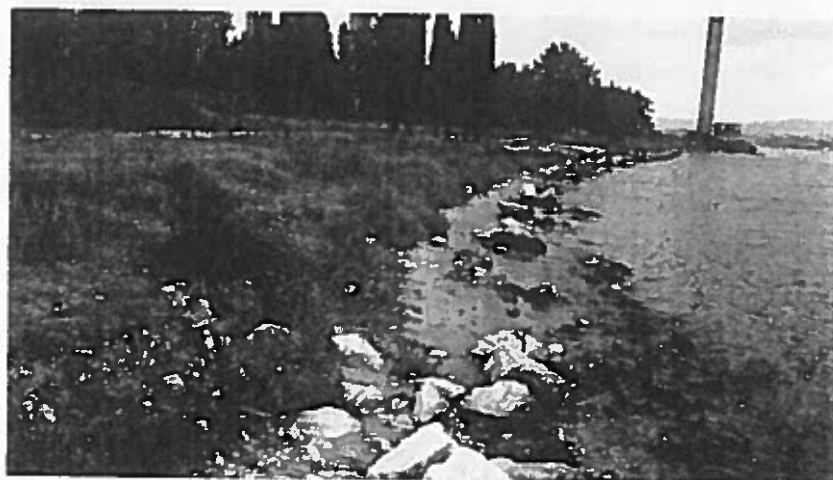
Фиг. 5 Участък 2 (снимка „Хидроремонт ИГ“, септ. 2015 г.)
