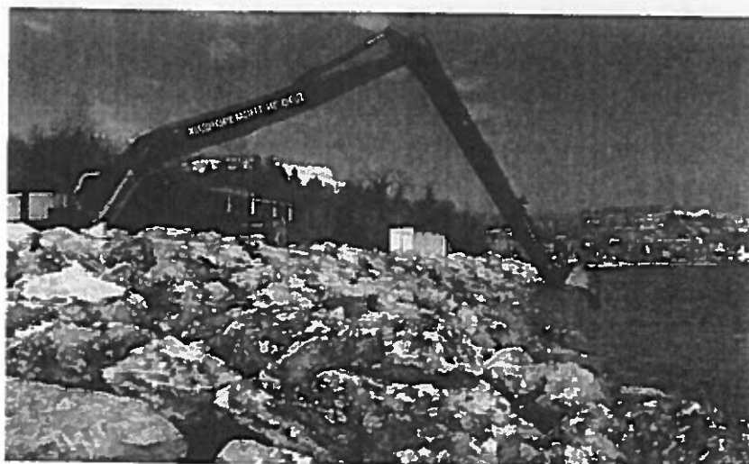
Фиг. 13 Изпълнение на брегоукрепване чрез верижен багер, разположен на сушата.
