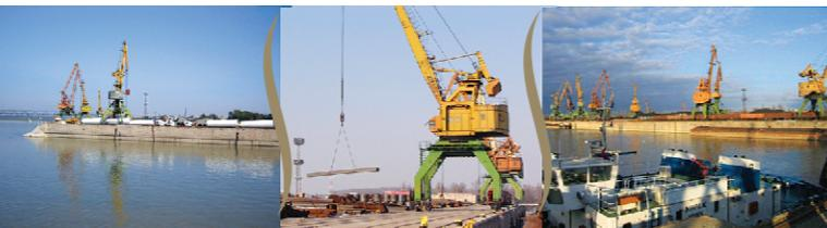
Терминалът има технически капацитет за обработка на голямотонажни единици до 64 т. Разполага с 14 корабни места. Възможна е обработка на товари с по-голямо тегло или нестандартни размери с помощта на 100-тонен плаващ кран. В него се обработват всички видове товари, включително едрогабаритни товари и техника. Русе-Изток има връзка с жп и автотранспортната мрежа на България.
