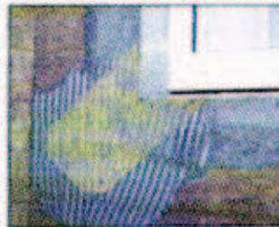
Залепване на допълнителна диагонално разположена армировка при ъглите на отворите
