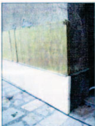
**Изолiranje на цокъла с плочи XPS. Вижда се позицията на металния профил и първият ред плочи Fastrock**
