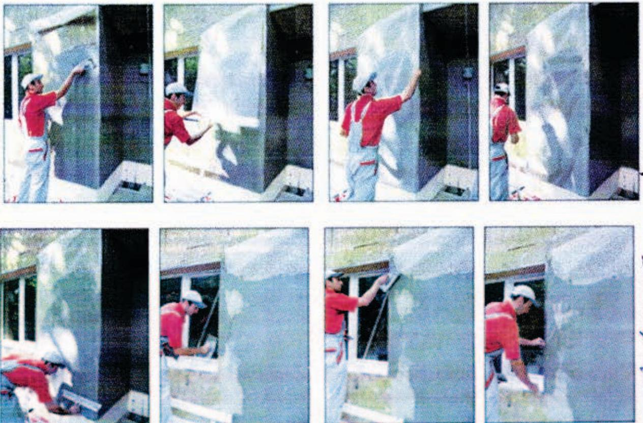
*Последователност на работата при нанасяне на шпакловката, поставяне на металните ъгли профили, опъване на армировъчната мрежа, нейното притискане и покриване с лепило, оформяне на ръбовете около прозорци*
