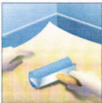
Целта на студеното или горещо заваряване е да се получи ефективно и здраво свързване на два края на подово покритие от един и същи вид. Едновременно предпазва от проникване на вода и служи като защита на краищата срещу механични агресии, дължащи се на трафика.
