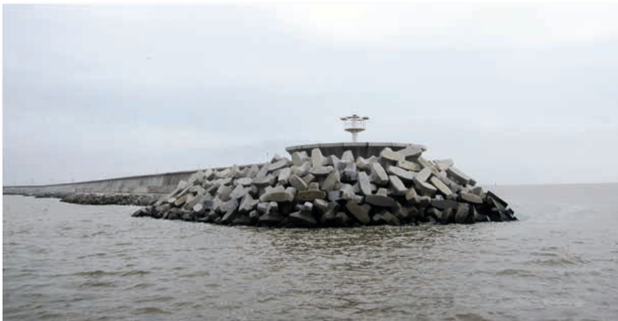
Фарът на челото на новия мол в пристанище Бургас, 2010 г. Снимка Държавно предприятие „Пристанищна инфраструктура“ Lighthouse at the front of the new mole, Port of Burgas, 2010. Photo by Bulgarian Ports Infrastructure Co.
