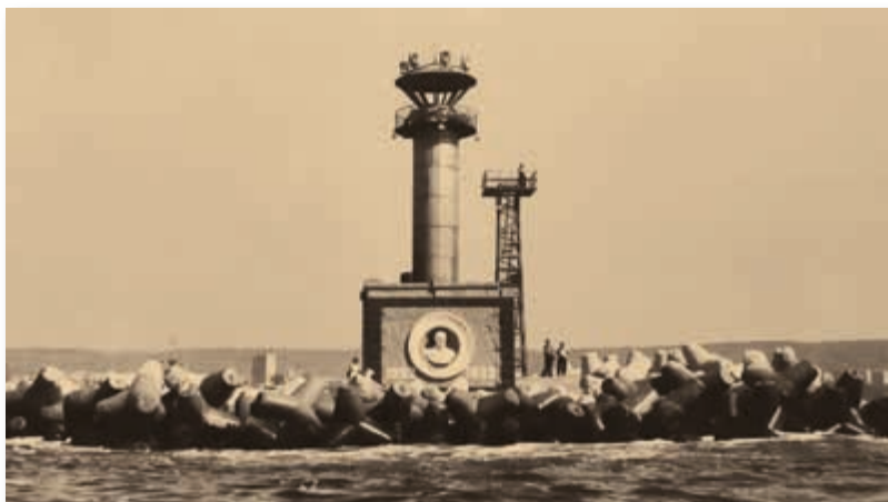
Фарът на Варна по време на ремонта в края на 80-те години. До него е временната ажурна конструкция. Архив на „Морски вестник“
