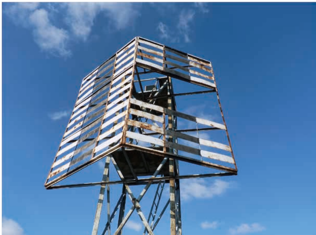
Несветещият навигационен знак Лакна, сниман откъм морето. Добре се вижда липсата на четири хоризонтални ленти от средата на десния (гледан откъм морето) щит, 2015 г. Снимка Евгений Аладжов Unlit beacon Lahna, photographed from the sea. The lack of four horizontal bands in the middle of the right (viewed from the sea) shield is clearly seen, 2015. Photo by Evgeniy Aladzhov
