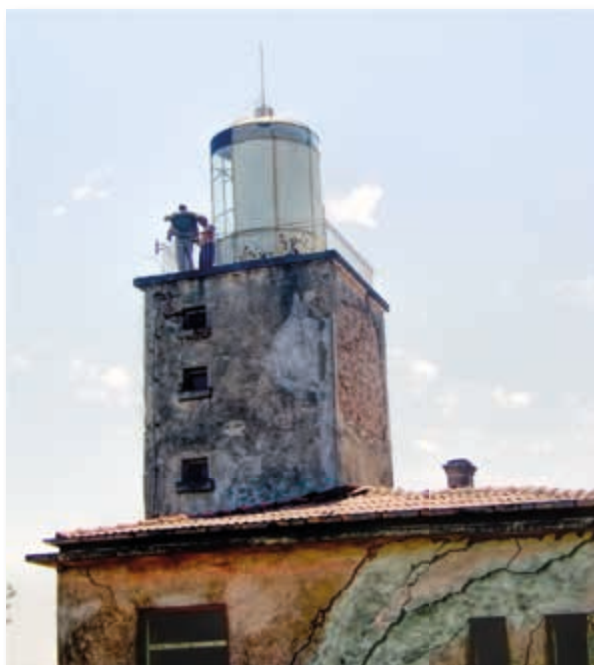
Фарът и постройката към него през 2006 г. Ясно видими са напукванията по стените.
