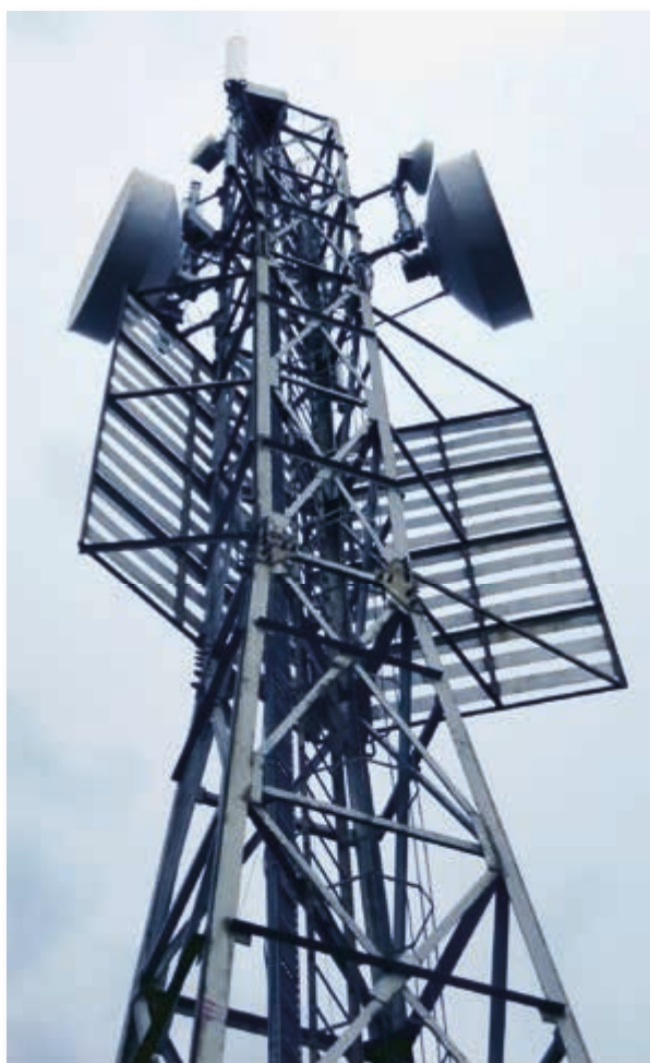
Навигационният знак на връх Буджака, поглед от запад, 2018 г.
