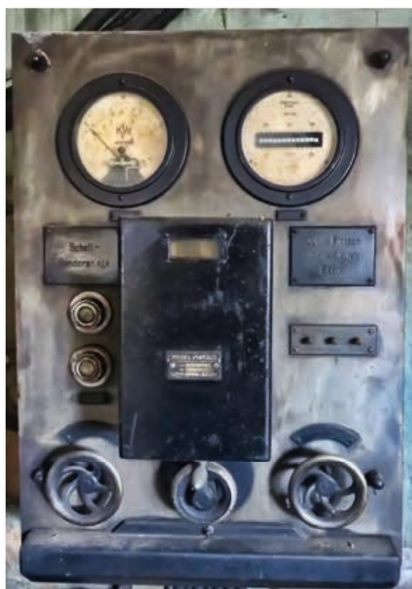
Част от апаратурата за управление на наутофона на фар Свети Иван, 2016 г. Снимка Атанас Панайотов
