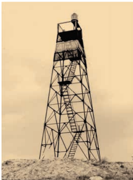
Светещият навигационен знак на Балчик през 1984 г. Ясно се вижда фаровата глава на върха на съоръжението и боядисаните в черно и бяло дървени щитове. Архив на Хидрографската служба на ВМС
