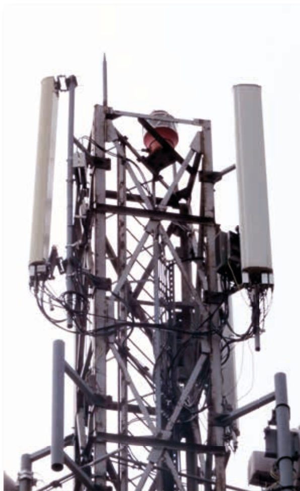
Навигационният знак на връх Буджака, поглед към най-горната му част, 2018 г.
