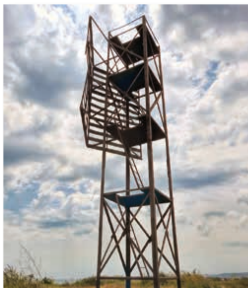
Несветещият навигационен знак Бели нос, сниман от страни. Тук добре се виждат вертикалните площадки и възможността за достъп до тях чрез стълби и правоъгълни прорези във всяка от площадките, 2016 г.
