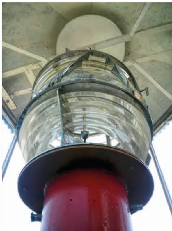
Фенерното отделение със съвременната оптика, 2016 г. Снимка Мариана Кръстева
