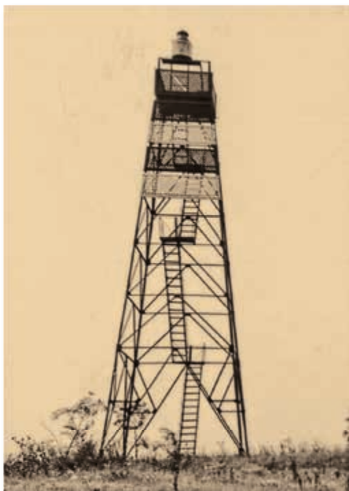
Светецният навигационен знак на Камен бряг през 1983 г. Ясно се вижда фаровата глава на върха на съоръжението и боядисаните в черно и бяло дървени щитове. Архив на Хидрографската служба на ВМС
