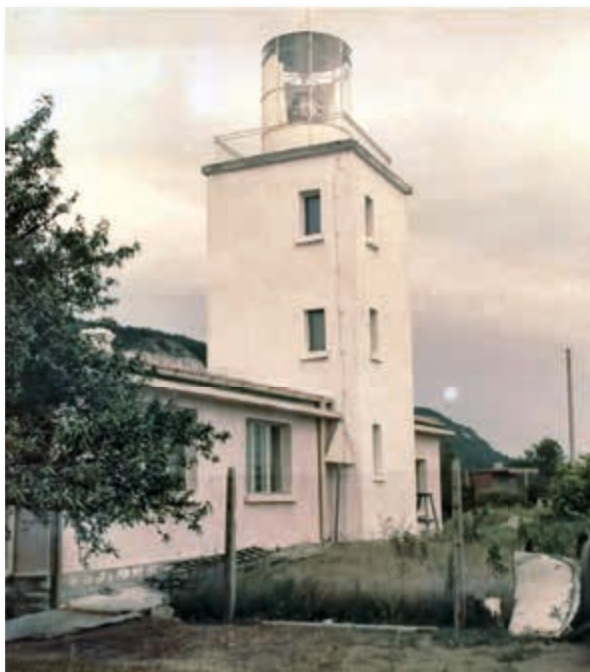
Фар Екрене скоро след изграждането му Ekrene Lighthouse, soon after its construction.
